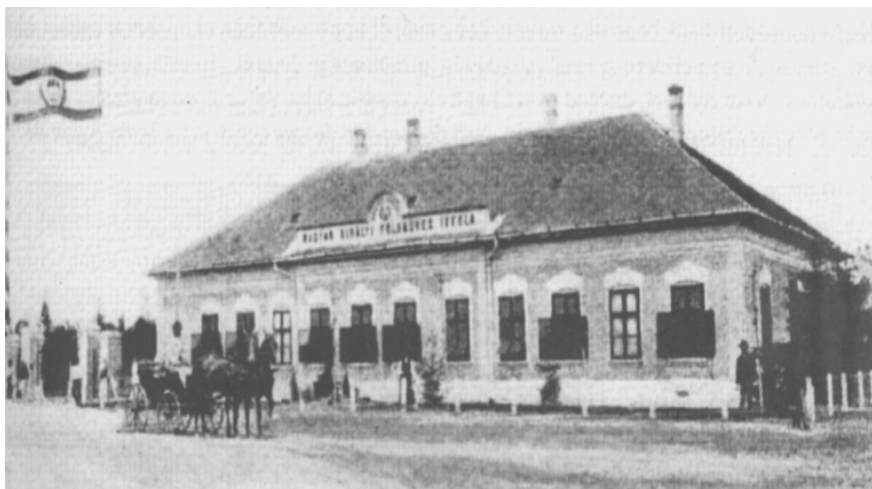
Clădirea principală a primei Școli Agricole din Ungaria, construită în anul 1799, la ordinul contelui Christoph Nákö , situată la capătul străzii Calea Szegedinului.
