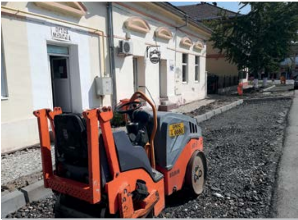
Lucrări de amenajare a parcărilor de pe strada Victor Babeș
