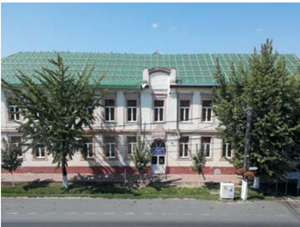
Reabilitarea acoperișului la Școala Gimnazială nr. 1
